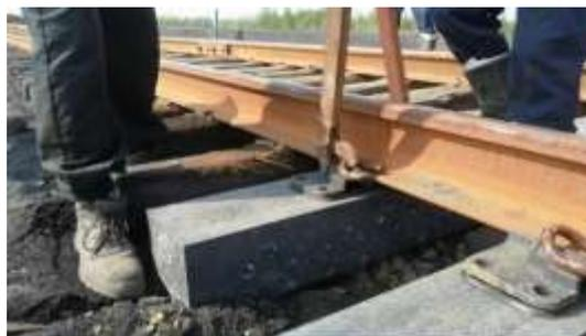
**Рис. 8. Установка композитных шпал**
