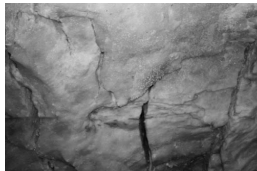
Рис. 2. Западный транспортный уклон в отм. –240 м (а) и участок обнажения в выработке, пересекающей междуканальный целик на гор. –160 м (б)
