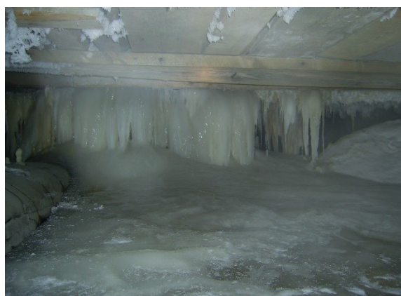
Рис. 5. Длительные утечки из коммуникаций приводят к растеплению грунтов, приносу загрязнителей в грунтовую влагу
