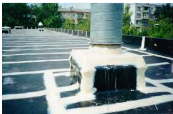
Рис. 5. Гидроизоляция жидкой резиной «Унимаст» [2]
