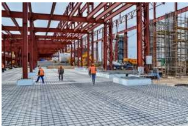
Рис. 2. Пристройка к имеющемуся зданию
