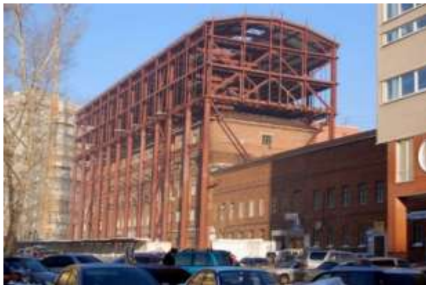
Рис. 1. Надстройка имеющегося здания
