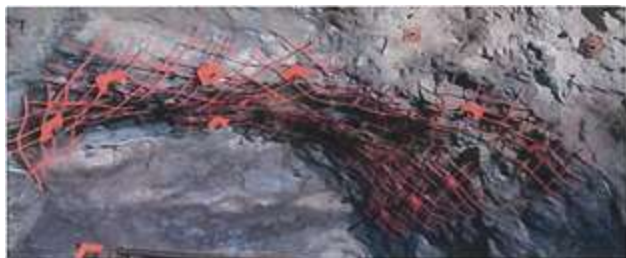
Рис. 3. Установленные АТФ-В с армокаркасами в горной выработке
