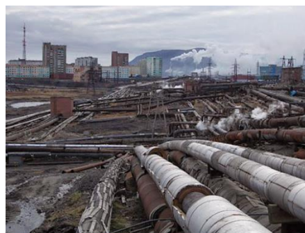
Рис. 1. Прокладка трубопроводов на Крайнем Севере [3]
