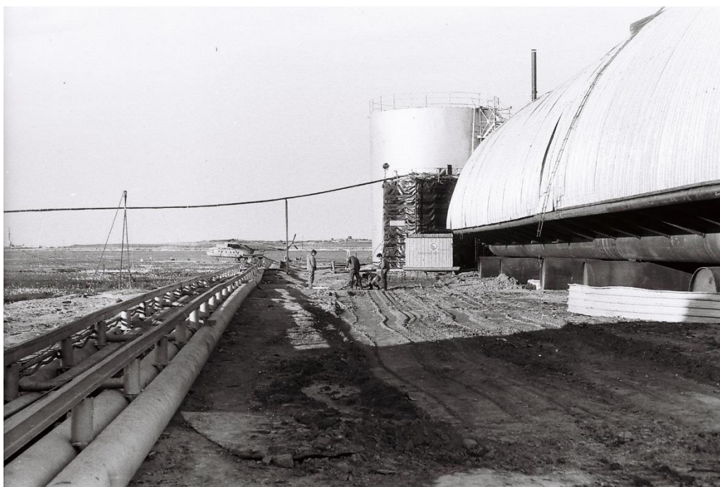
Рис. 2. Площадка ЯВМУ Бованенского ГКМ на п-ове Ямал – вспомогательные сооружения: трубопроводы, резервуары, ангары и др.
