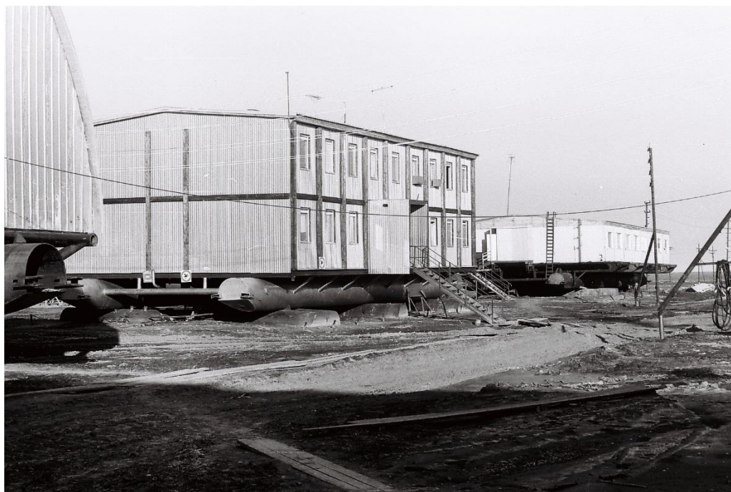
Рис. 1. Площадка ЯВМУ Бованенского ГКМ на п-ове Ямал – жилой комплекс в вахтовом поселке – вспомогательные сооружения: трубопроводы, резервуары, ангары и др.
