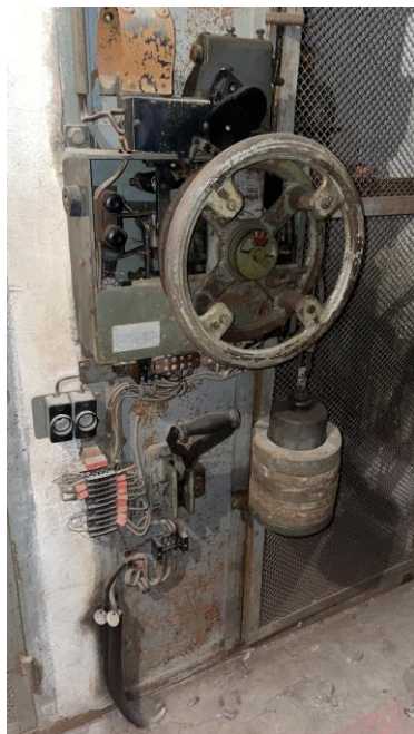
Рис. 4. Оборудование, требующее профилактического обслуживания. Привод грузовой ручной 1962 г. выпуска (с двух ракурсов)
