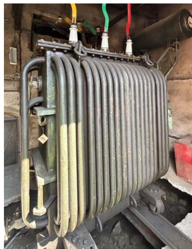
Рис. 1. Трансформатор ТМ-1000/6
