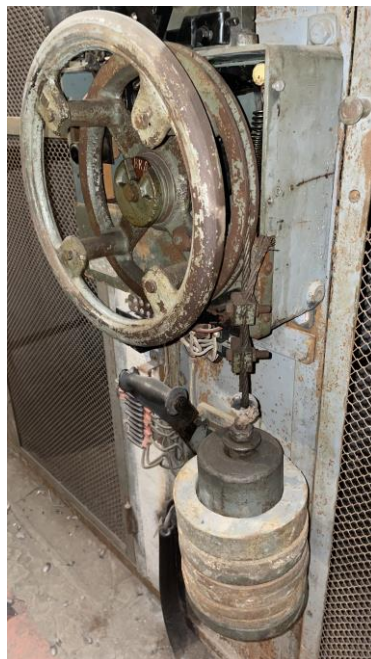
Рис. 4. Оборудование, требующее профилактического обслуживания. Привод грузовой ручной 1962 г. выпуска (с двух ракурсов)
