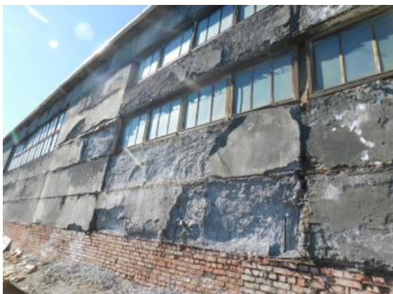
Рис. 6. Разрушение стеновых панелей
