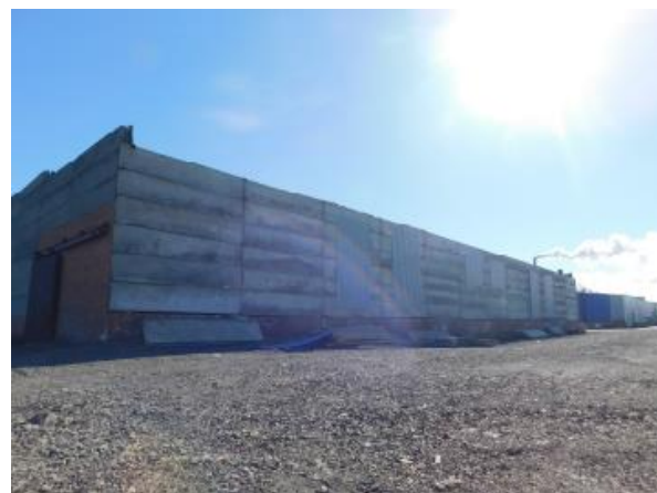
Рис. 1. Здание теплого склада
