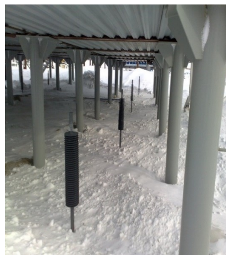
Рис. 5. Принцип действия термостабилизатора
