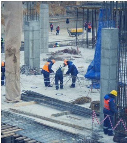
Рис. 4. Строительство нового города Инувика на скальном основании
