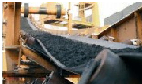
Рис. 6. Вид конвейера с установленной системой лазерного 2D измерения, специально разработанной для решения задач контроля и учёта объёмов заполнения конвейерной ленты
