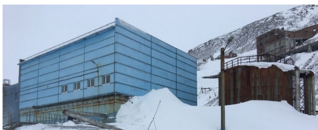
Очистные шахтных вод рудника «Заполярный»
