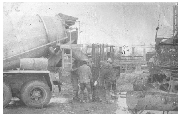
Рис. 6. Подача бетона в скважину буронабивным способом
