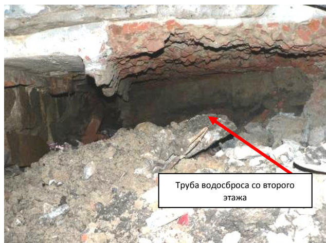
Рис. 15. Дефекты водосборного приемки здания
