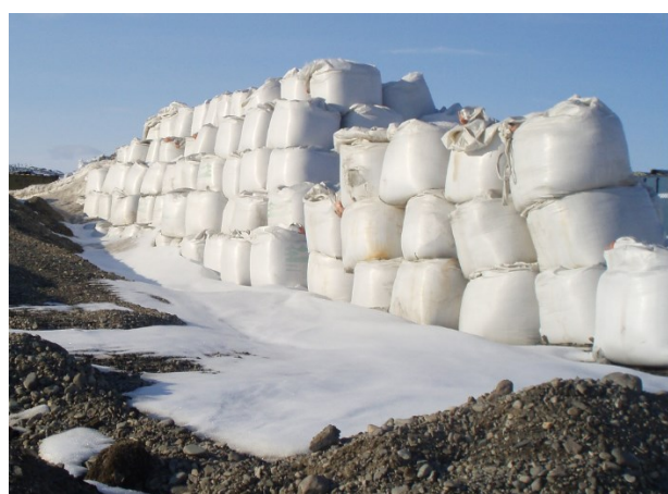
Рис. 4. Хранение цемента на Крайнем Севере
