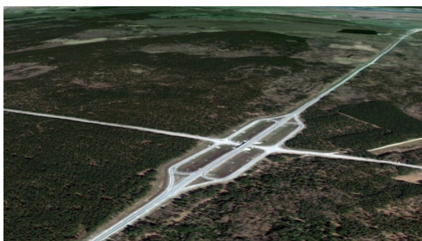
Рис. 1. Самая крупная кольцевая развязка на участке Северного объезда г. Новосибирска
